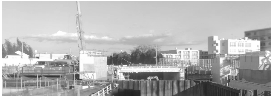
周辺に大きな地下水の水位低下をもたらしている真間川での工事
